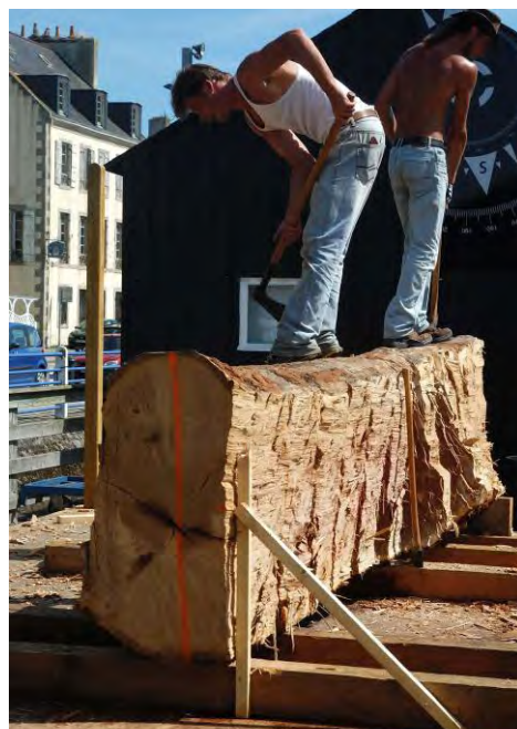
Figure 16 : Creusement à l'identique d'une pirogue médiévale (août 2012) © Adramar.
