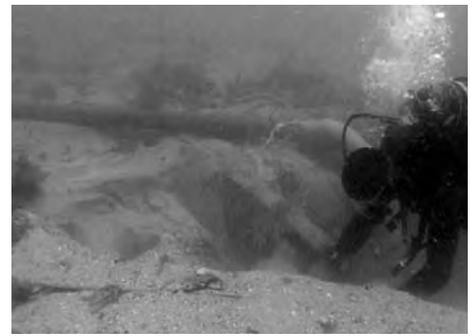
Fig. 19. Désensablage du géotextile posé en août 2002.
