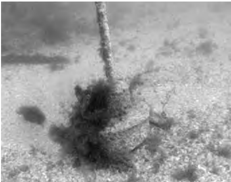
Fig. 8. Vestige de la base de béton servant à positionner l'émetteur du PLSM. (image T. Boyer)
